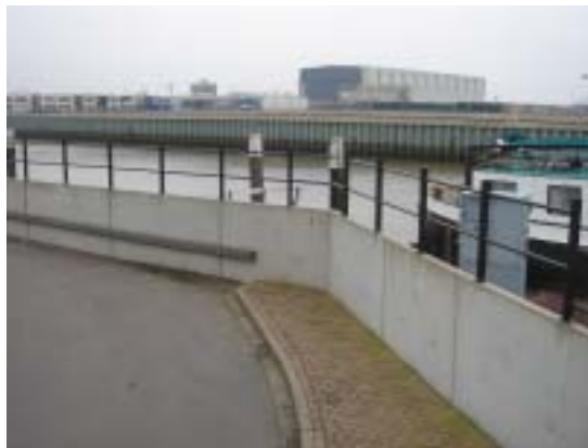
Een mogelijk geschikte locatie voor een fietsbrug naar de Stormpolder is van het einde van de Veerдам naar het EZK terrein.
